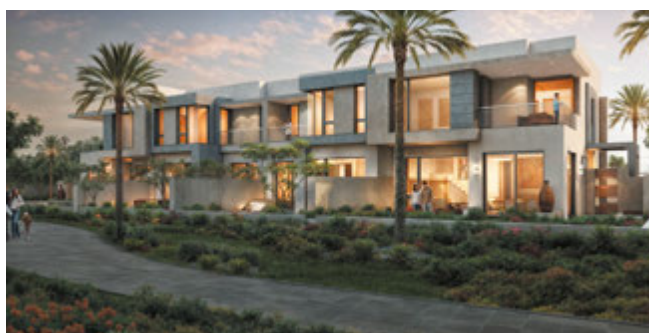
Комплекс вилл Maple в районе Dubai hills estate
